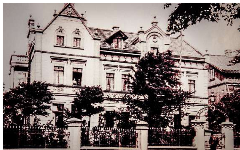
Diese historische Fotografie zeugt von imposanter Präsenz des Gebäudes. Im Zweiten Weltkrieg wurde es schwer beschädigt.
